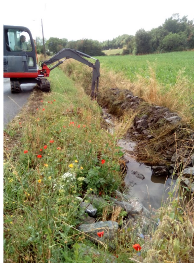
Fossé de Chaponneau : tranchée de reprofilage fossé avec un curage pour améliorer l'écoulement des eaux de pluie.
