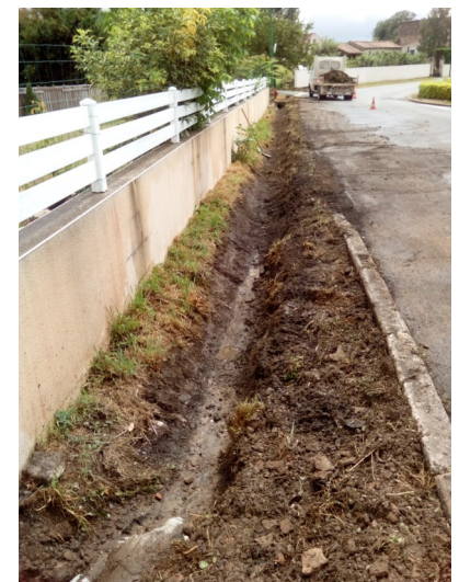
Rulon : tranchée de reprofilage fossé avec un curage pour améliorer l'écoulement des eaux de pluie.
