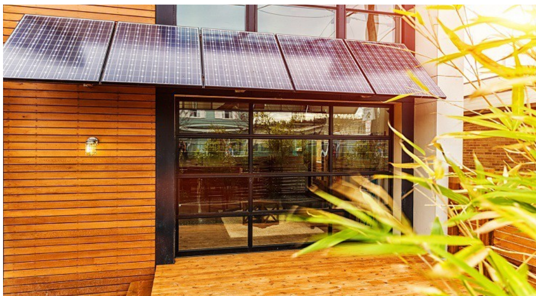
Panneaux solaires en façade formant une ombrière
